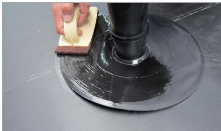
Використовуйте ґрунтовку на нижній стороні збірної основи та на мембрані, де буде використовуватися збірна конструкція.
