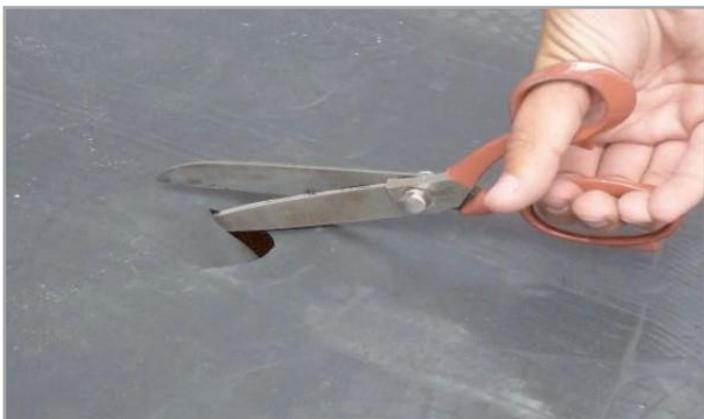
Встановіть мембрану EPDM і виріжте круглий отвір над водостічної трубою. Отвір має бути приблизно на 10 мм меншим за діаметр зливної труби.
