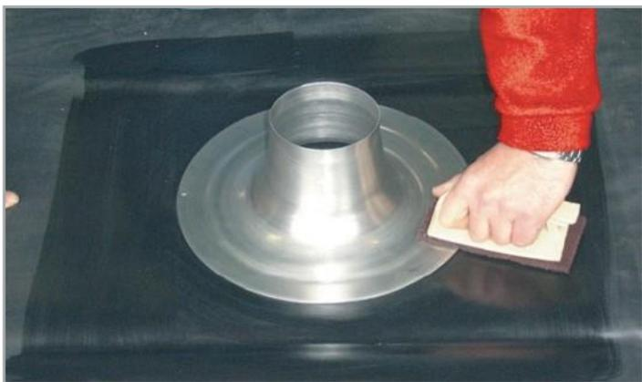
1. Позначте положення труби на мембрані. Зафіксуйте прокол труби на маркері. Використовуйте ґрунтовку на основі проколу труби та на 100 мм навколо.
