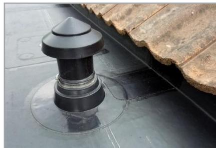
Увага: Для вентиляції на фланці труби встановлена стрічка для з'єднання EPDM.
