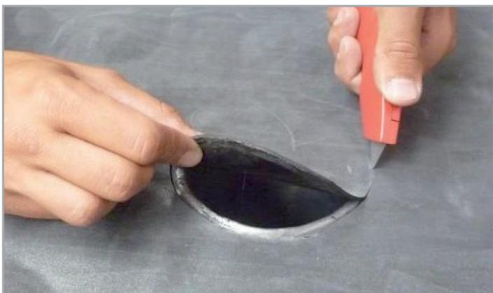
Зніміть захисну плівку та накрийте комір лійки, переконавшись, що нахлест по колу становить мінімум. 50 мм. Виріжте в самоклеючій мембрані отвір так, щоб його діаметр був на 10 мм більше вхідної труби.
