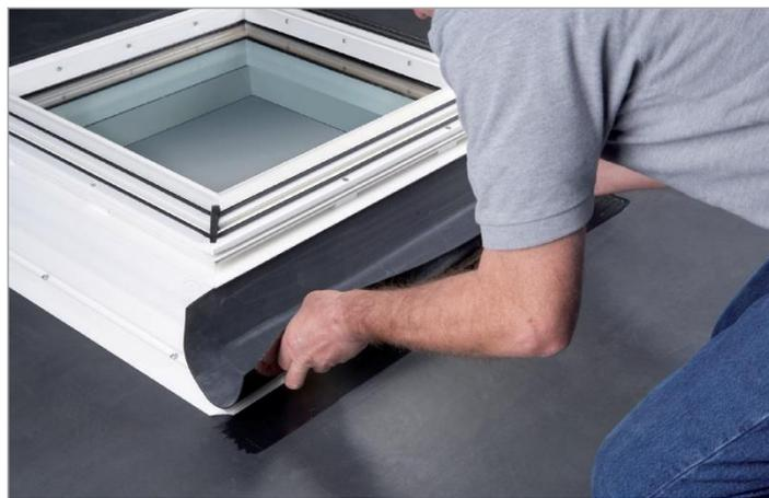
При герметизації мансардного вікна переконайтеся, що довжина самоклеючої мембрани EPDM дорівнює довжині основи світлового люку.
