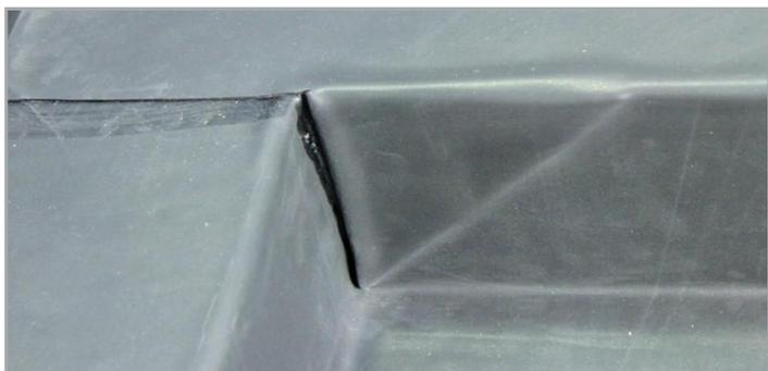
Типовий зовнішній вигляд внутрішнього кута, без готової верхньої частини.
