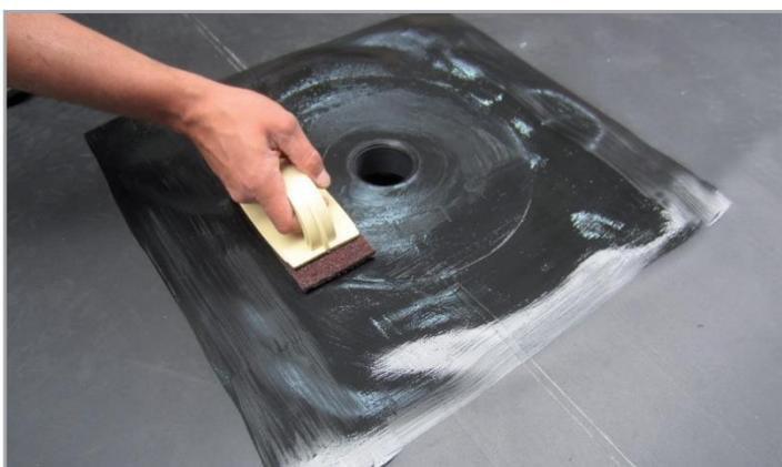
Встановіть збірну панель у водостічній трубі. Нанесіть ґрунтовку на комір лійки і навколо нього, мін. 75 мм. Комір лійки виготовлені з матеріалу, відмінного від EPDM, потребують кріплення кожні 100 мм.
