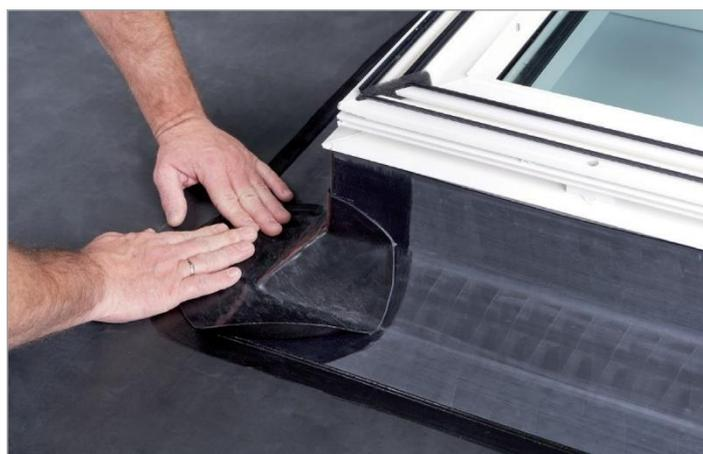
Після того, як усі сторони заклеєні клейкою мембраною, нанесіть ґрунтовку на кути та встановіть кути EPDM на кожному куті.
